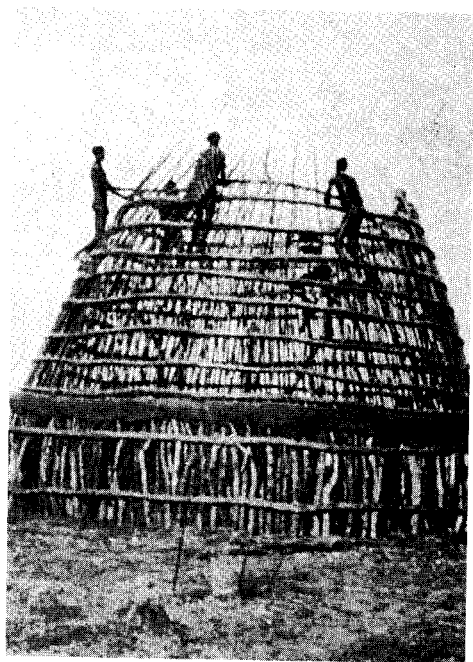
XVIII. Construcción de un establo para el ganado (jikany orientales)
